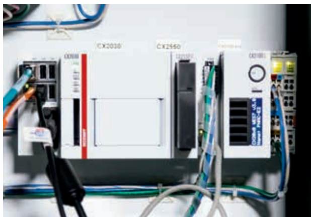
结构紧凑的信福 CX2030 嵌入式控制器用于运行仓库执行系统软件，并控制输送机和其它设备
