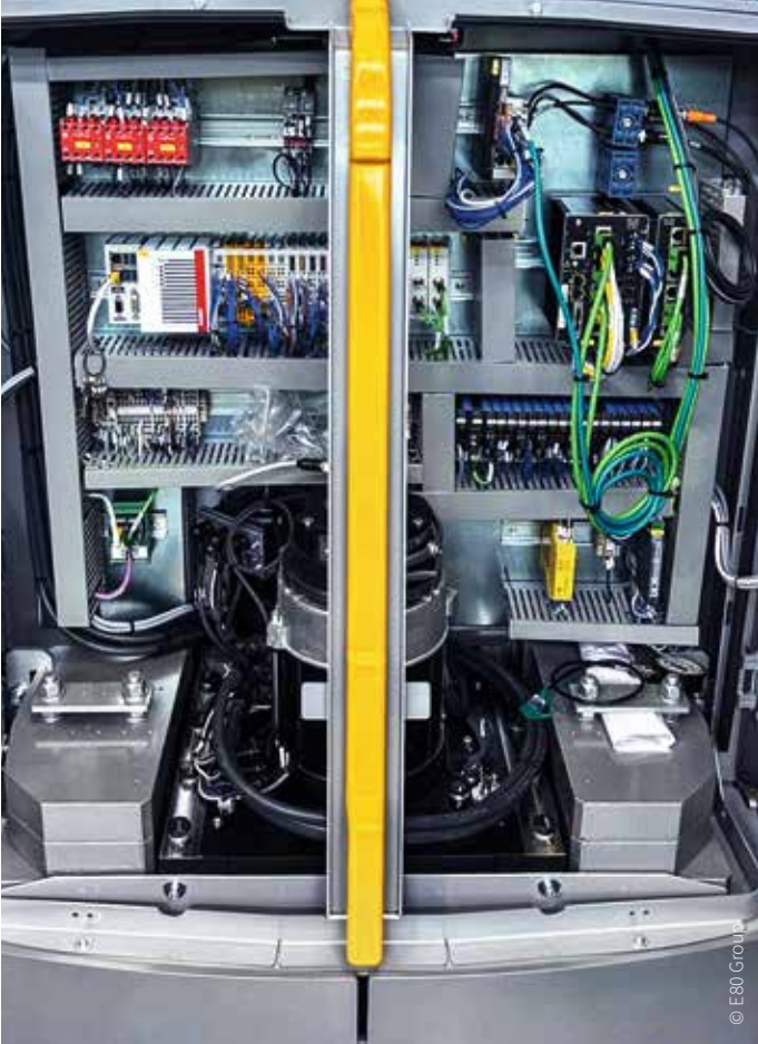
EtherCAT 端子模块与嵌入式控制器体积小巧,使 LGV 的整体结构更为紧凑
