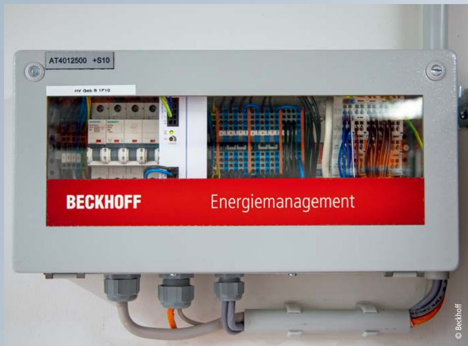
结构紧凑的嵌入式控制器和电能测量端子模块 用于采集生产过程中的能耗数据
