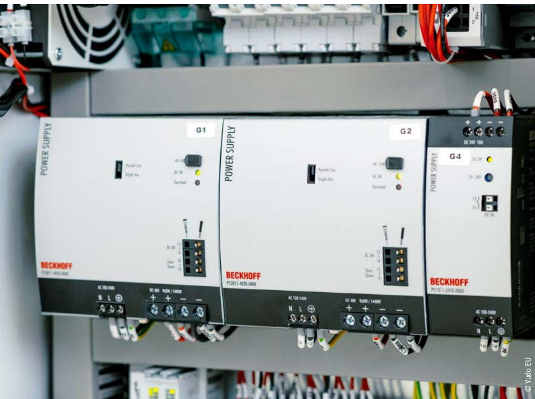
倍福 PS 系列 DIN 导轨安装式电源确保为安装有 EtherCAT 插拔式模块的信号分配板供电
