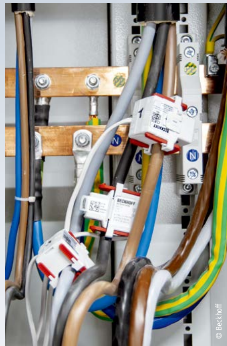
SCT 系列钳形电流互感器可以方便地改造并将现有的 设备和建筑集成到一个全面的能源管理系统中
