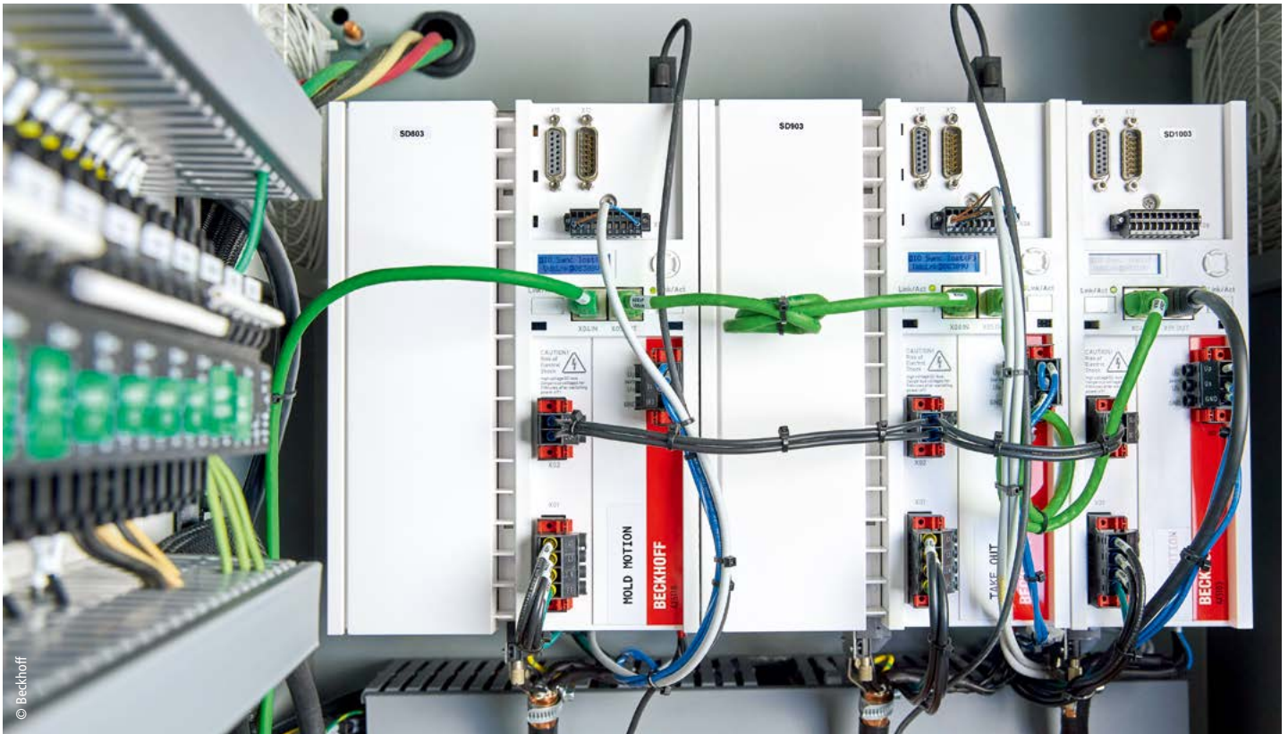
倍福的 AX5000 系列伺服驱动器用于高动态地控制螺杆、线性模具运动和侧装式机器人的运动
