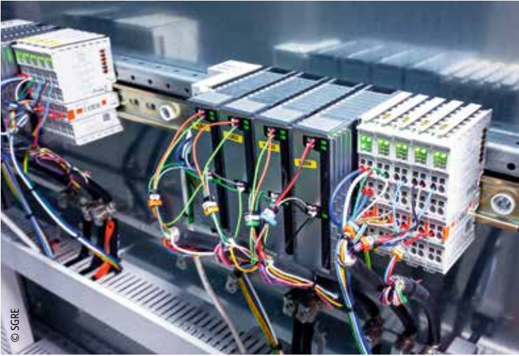
正在使用中的 ELM 3002-0205 高压测量端子模块（中间）
