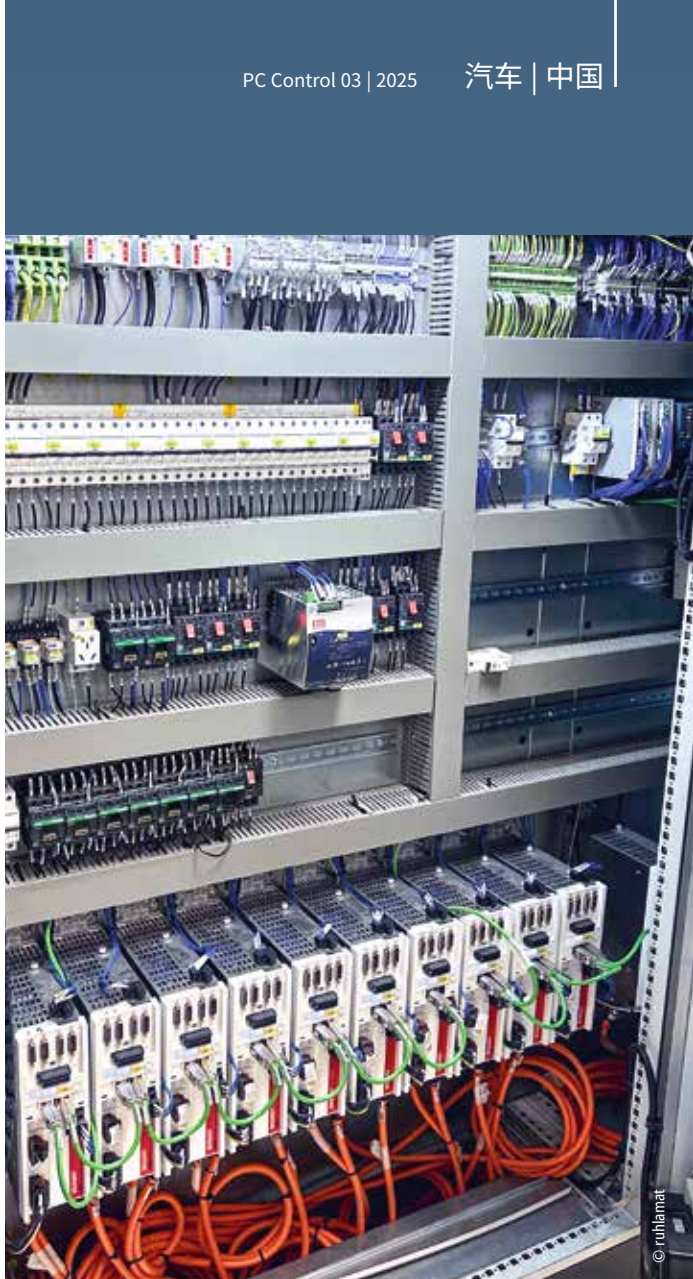
配备多台倍福 AX5000 伺服驱动器的控制柜(图下方)
