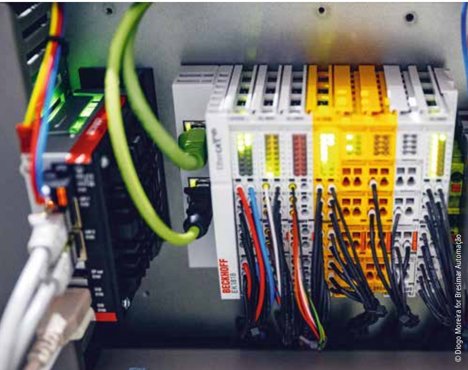
得益于 C6015 超紧凑型工业 PC (左) 与 EtherCAT 端子模块 (右) 的紧凑设计, 系统无需额外配置独立控制器
