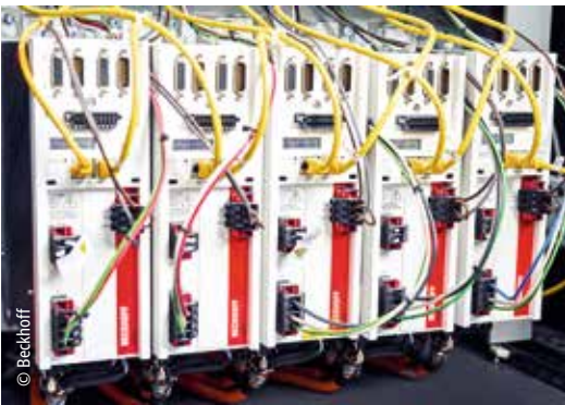
倍福 AX5201 伺服驱动器支持实现材料测试所需的高速、高动态定位任务
