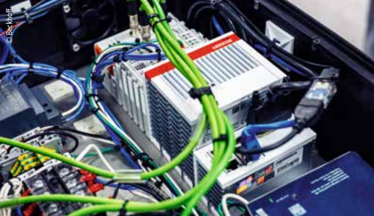
安装在“火蛇”装置便携式控制箱内的紧凑型 CX5140 和 CX8190 嵌入式控制器(图示为 CX5140)直接连接 EtherCAT I/O 模块
