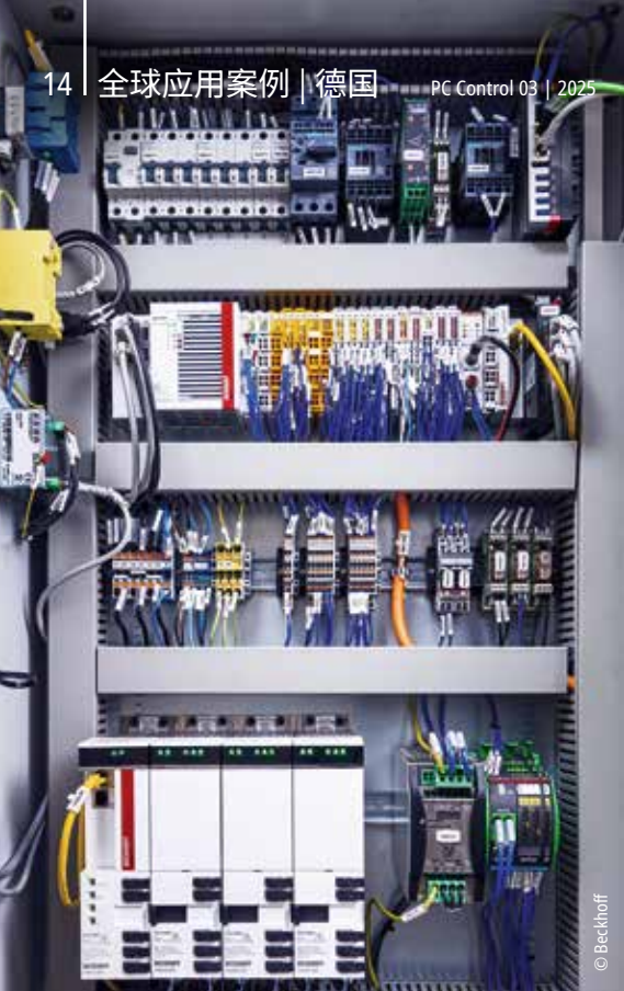
mySaw 带锯床的控制柜配置：顶部为 CX5240 嵌入式控制器及所连接的 EtherCAT 和 TwinSAFE 端子模块，底部为 AX8000 多轴伺服系统
