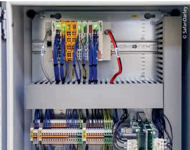
EtherCAT P I/O 站点通过一根兼具通信和供电功能（红/黑）的电缆，将轴、机械手以及传感器的分布式 I/O 连接至控制柜内的控制器
