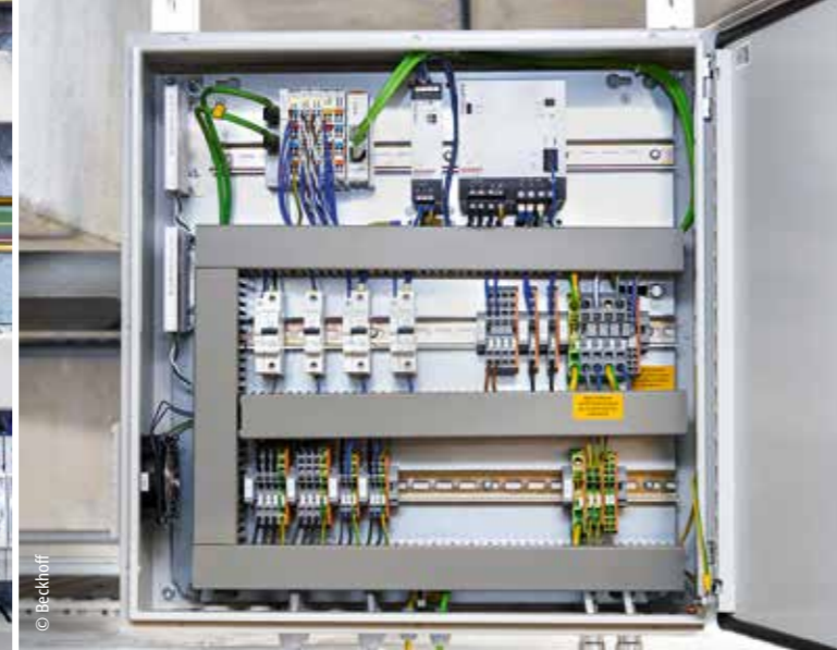
27 个配备倍福 PS3031-2440 电源模块的控制柜为 EP 端子盒分布式供电
