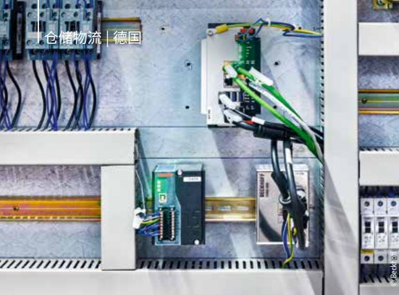
C6030 超紧凑型工业 PC 通过 EtherCAT 和 EP7402 紧凑型端子盒控制环形输送线的所有辊筒驱动装置
