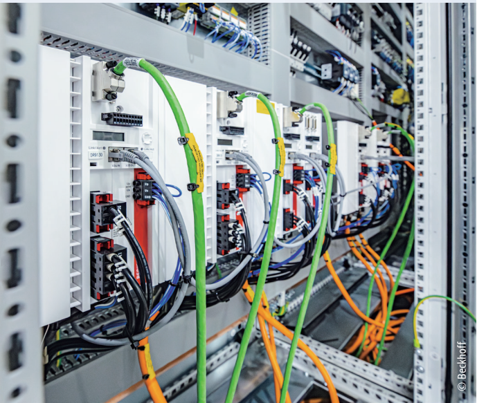
所有驱动轴都通过 AX5000 数字式紧凑型伺服驱动器实现精准控制
