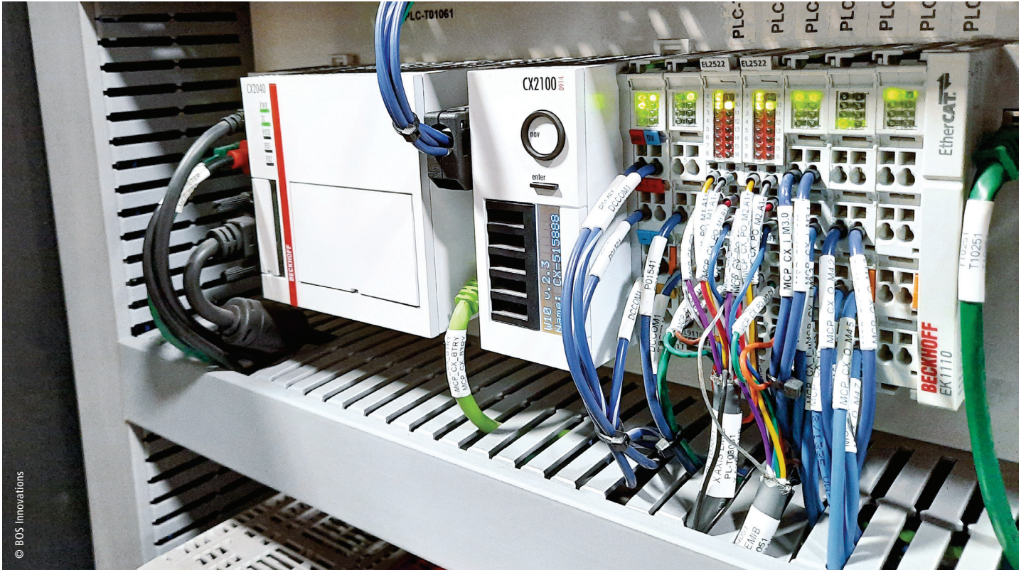
倍福的 CX2040 嵌入式控制器为协调高速激光切割机的五轴运动提供了足够的运算能力
