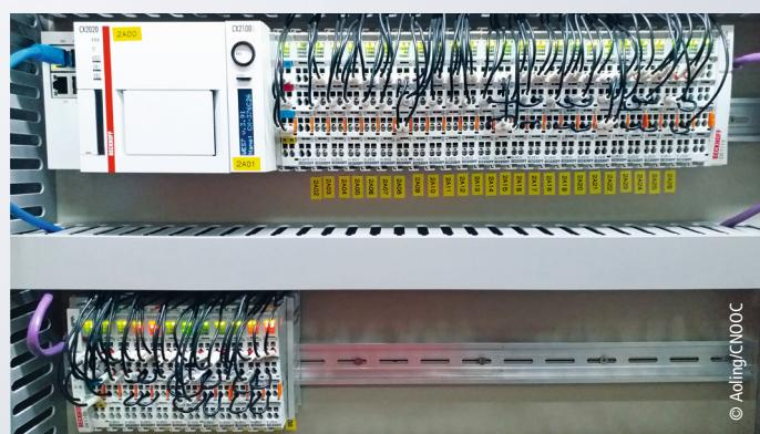
CX2020 嵌入式控制器和 EL3632 EtherCAT 模拟量端子模块构成了一个非常紧凑的控制和测量数据采集系统
