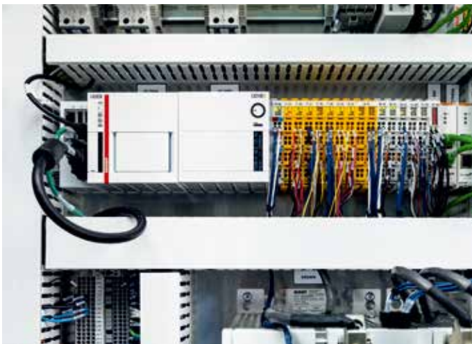
CX2020 嵌入式控制器控制整合设备，不再像以前那样需要使用多台传统硬件 PLC
