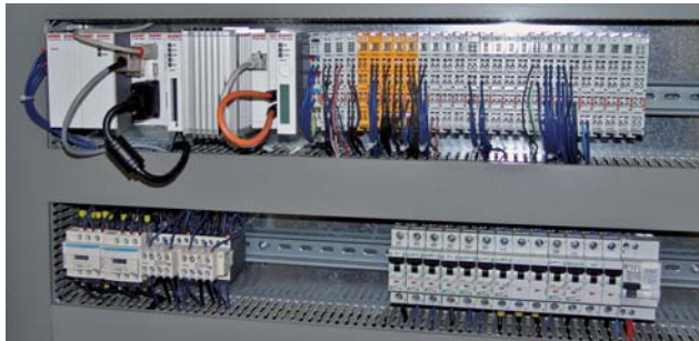
用 Beckhoff 嵌入式控制器切换和控制注胶单元的中心
