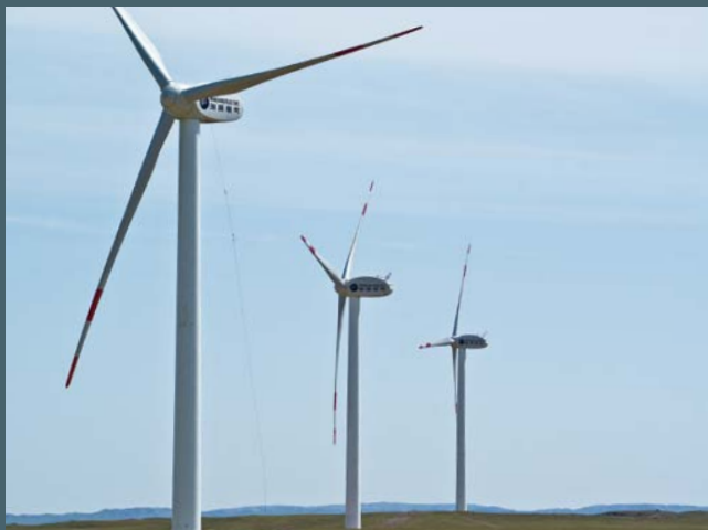
大唐吉林向阳风电场 100 台 1.5 MW 风力发电机并网发电，产能达 150 MW
