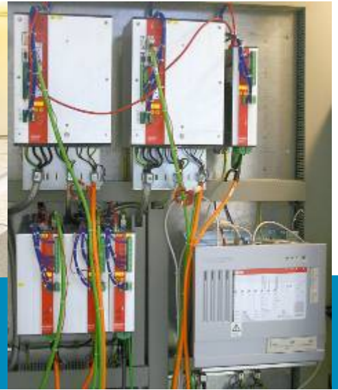
AX2xxx 系列伺服驱动器， 用于控制高动态直线电机
