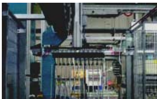
插图 2: 由两台 Beckhoff 伺服放大器控制的机器人在注塑线上安装电缆。
