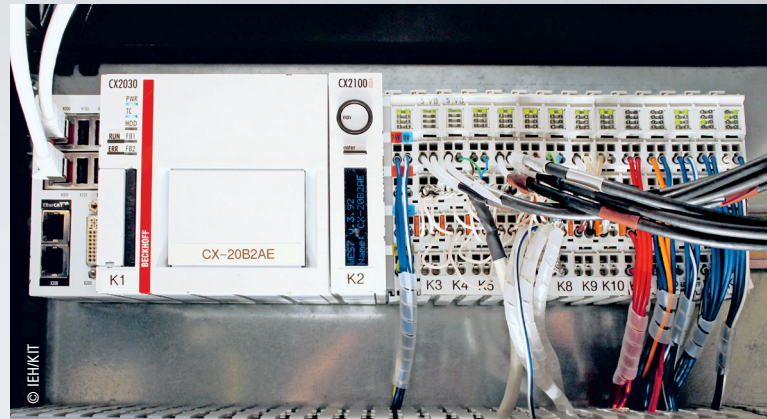
对于逆变器仿真，CX2030 嵌入式控制器可以实现 50 \mu s 的短控制周期
