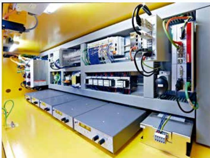
91 个波荡器单元的每一个都由基于 PC 的控制系统控制系统由一台控制柜式 PC C6925 (右) 大量 EtherCAT 端子模块 (中间) 以及 2 个 AX5206 伺服驱动器 (左) 构成
